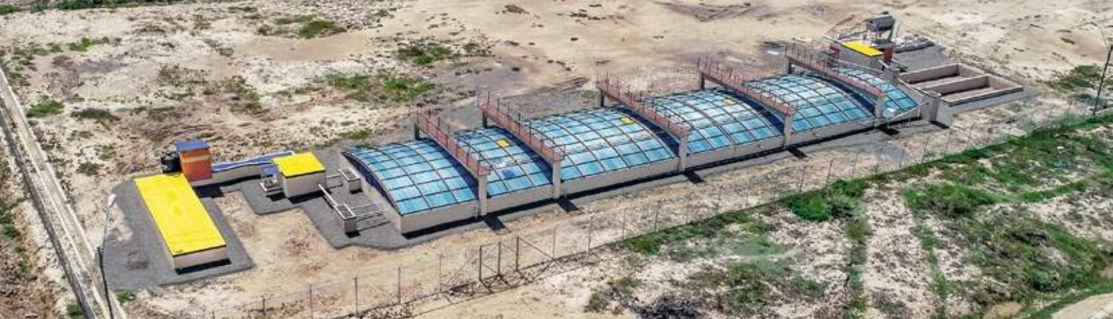
▲ Vista aérea PTAR Zona Norte - Cochabamba.
