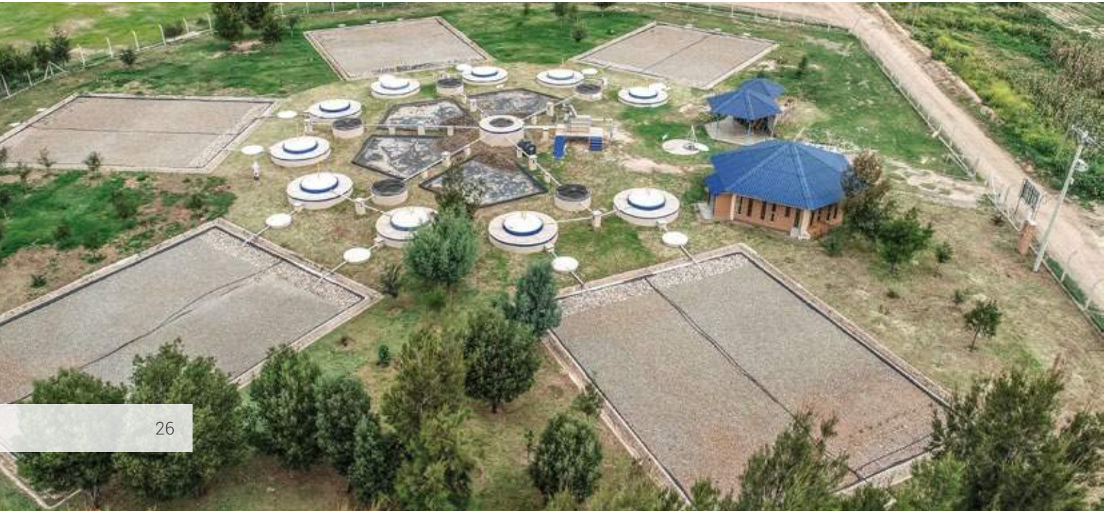
▼ Vista aérea PTAR Villa el Carmen - Cochabamba.
