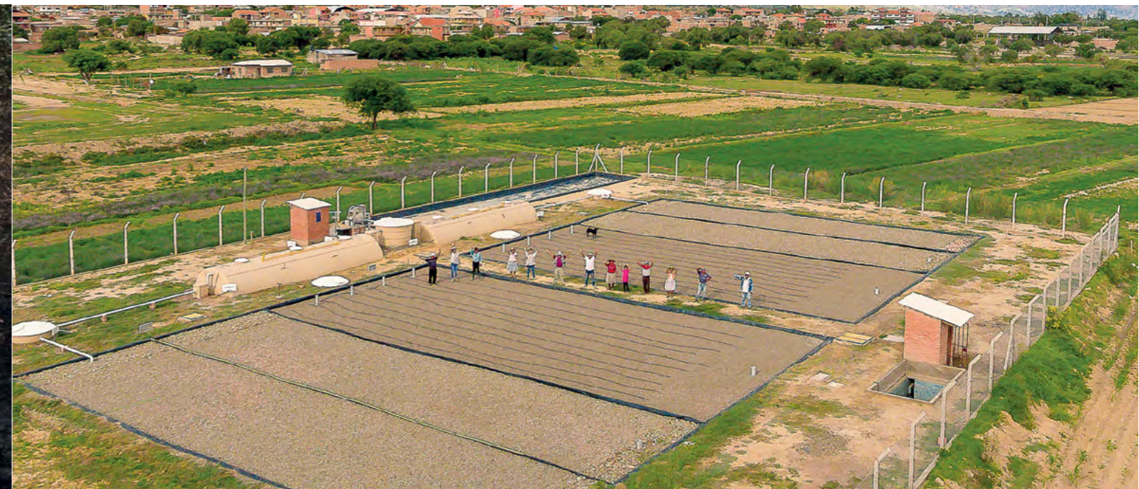
Fotografía: Nueva planta de tratamiento de aguas residuales de Tolata
