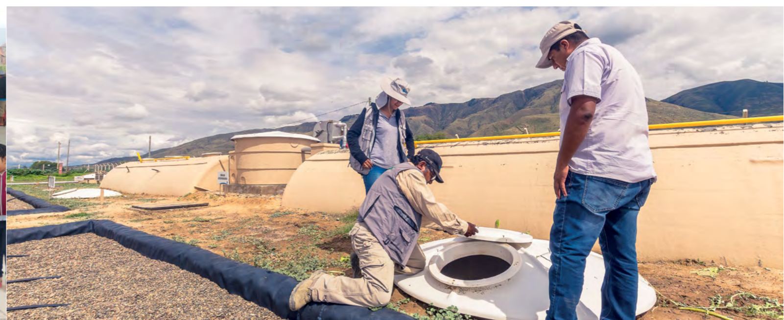
Foto: Operación y mantenimiento de la PTAR Tolata
