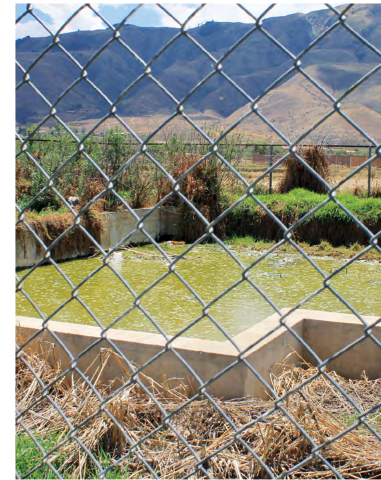
Fotografía: Planta de tratamiento de aguas residuales antigua
