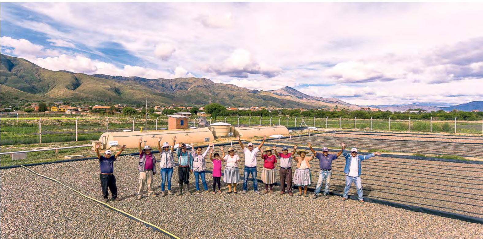
Fotografía: Planta de tratamiento de aguas residuales de Tolata
