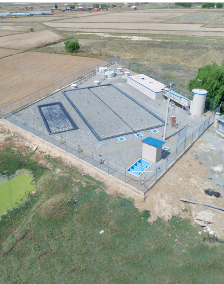
Fotografía: Planta de tratamiento de aguas residuales. Municipio de Cliza.
