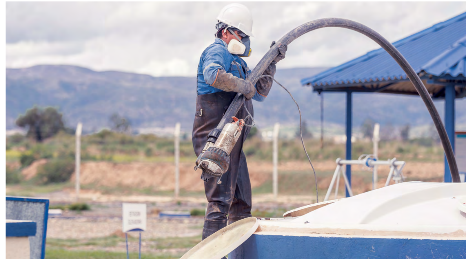
Fotografía: Mantenimiento de bomba PTAR Cliza
