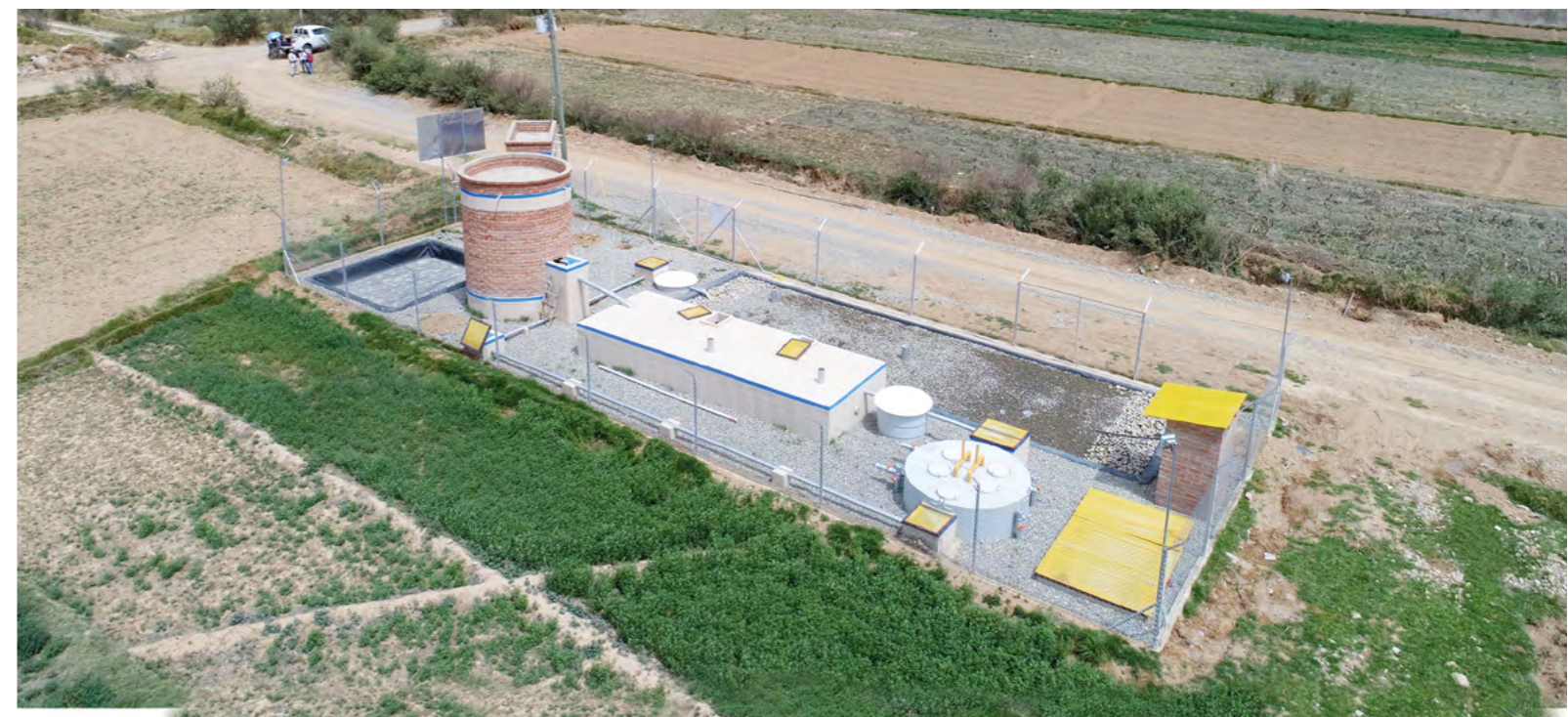
Fotografía: Planta de Tratamiento de Aguas Residuales de Cliza
