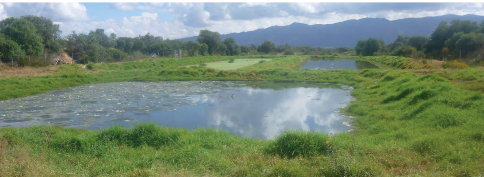
Fotografía: Antiguas Lagunas de tratamiento de aguas residuales, Cliza
