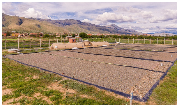
Fig. 8: Filtros de grava horizontales y verticales en Tolata (2019)
