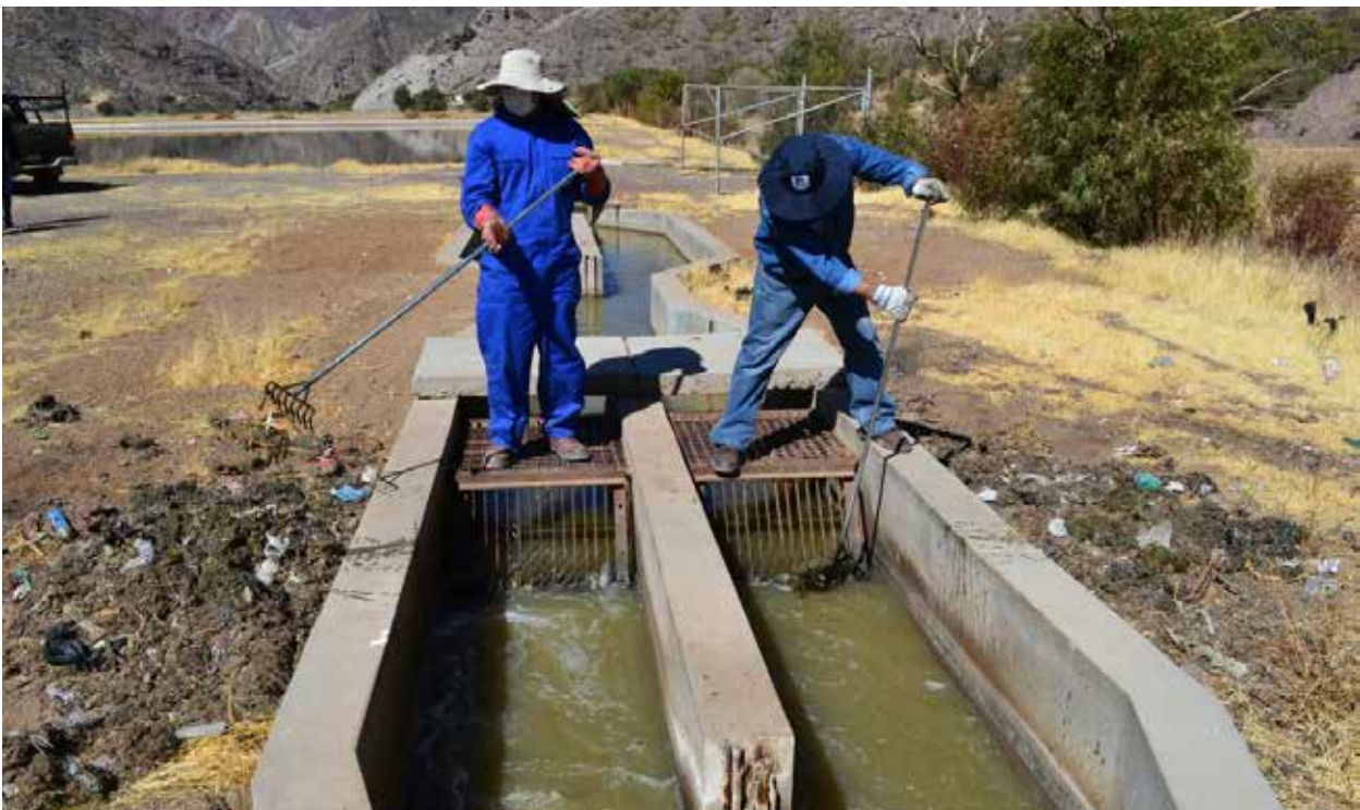
Obreros realizan el mantenimiento en la PTAR de Tupiza.
