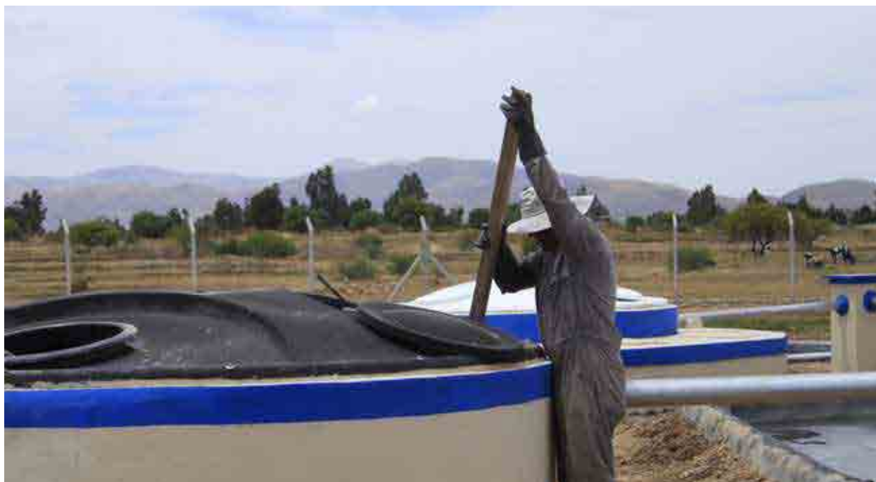
Mantenimiento de la PTAR en Cliza.
